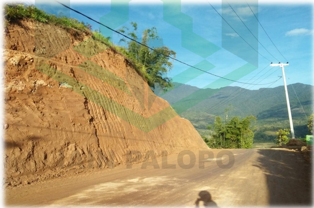
Gambar 4.4 Hasil pekerjaan pelebaran jalan
