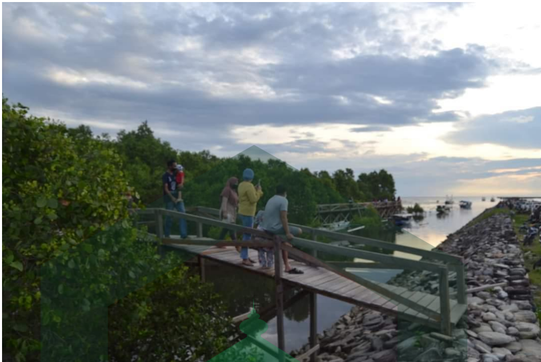
Kondisi jembatan titian sebelum pengecatan
