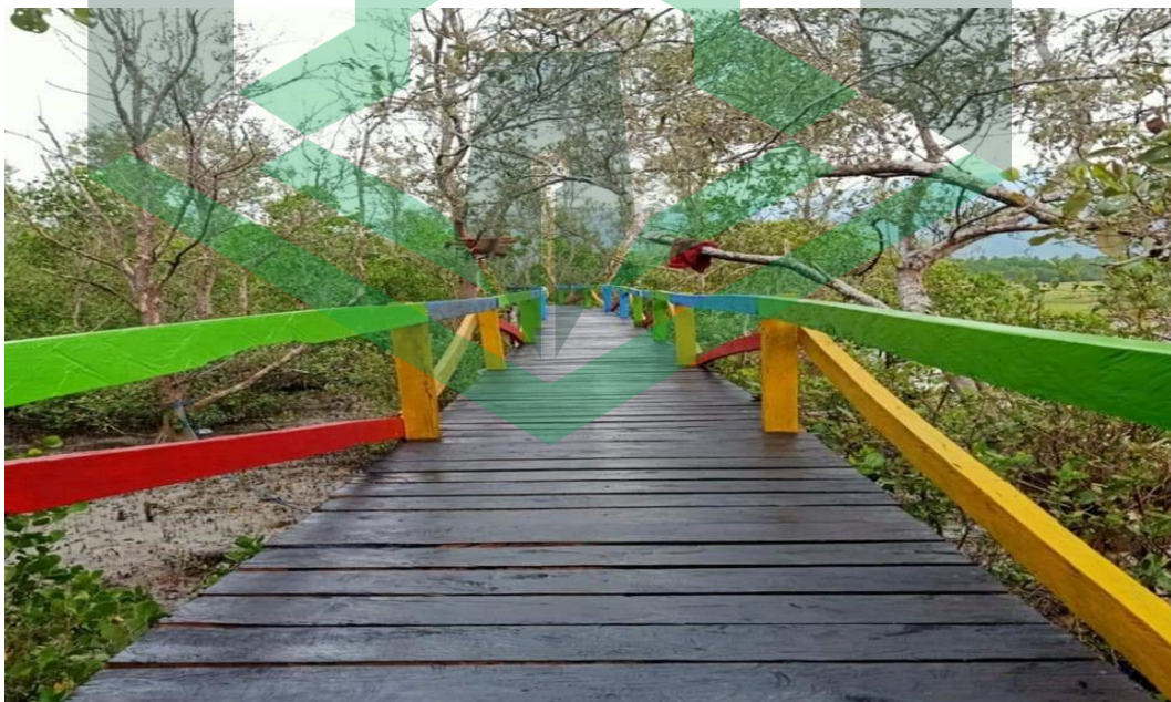
Tahap pengecatan jembatan titian
