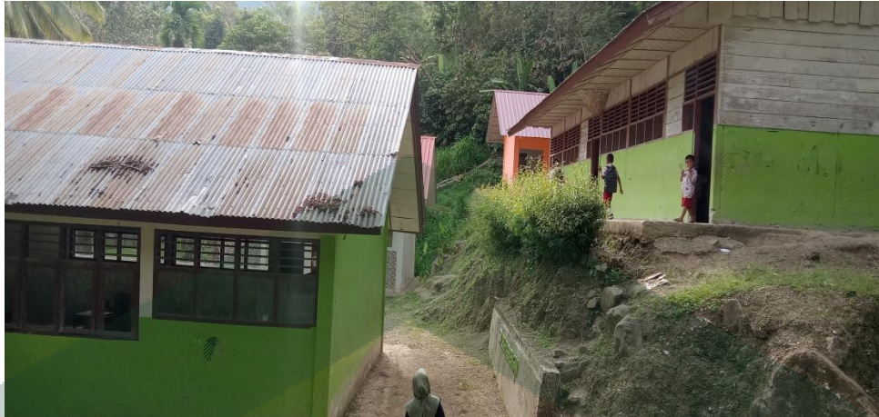
Dokumentasi Gedung Sekolah UPT SDN No. 6 Rano Kabupaten Tana Toraja
